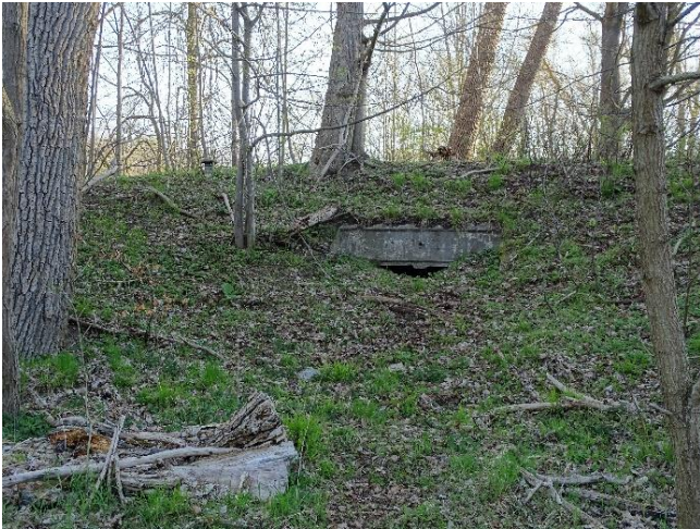
Abb. 12: Als Fledermausquartier hergerichteter Bunker auf dem ehemaligen Kasernengelände
