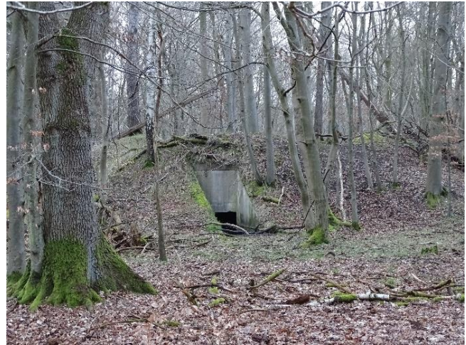
Abb. 13: Gefluteter Bunker auf dem ehemaligen Kasernengelände
