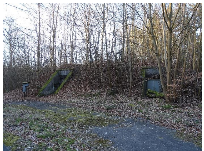
Abb. 11: Intakter Bunker innerhalb der Muna
