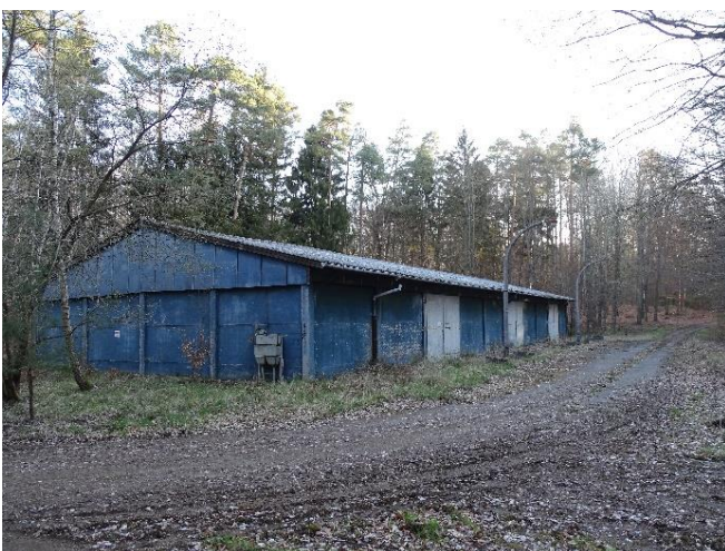
Abb. 10: Eine der vielen Lagerhallen im Westen der Muna
