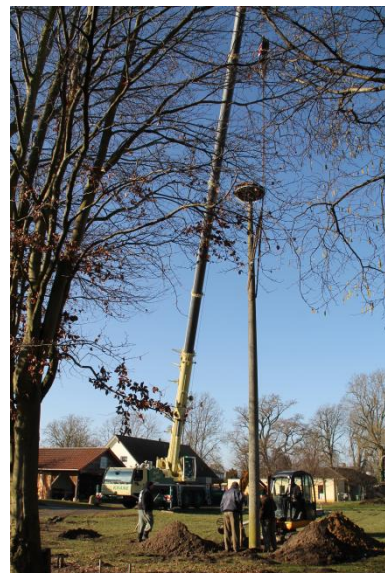
Abb. 5: Nistmastumsetzung in Hohen Spreng am 02.2.2021
