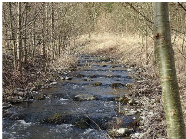
Abb. 8: Fischaufstiegsanlage als Übergang von der Nebel zum Teuchelbach
