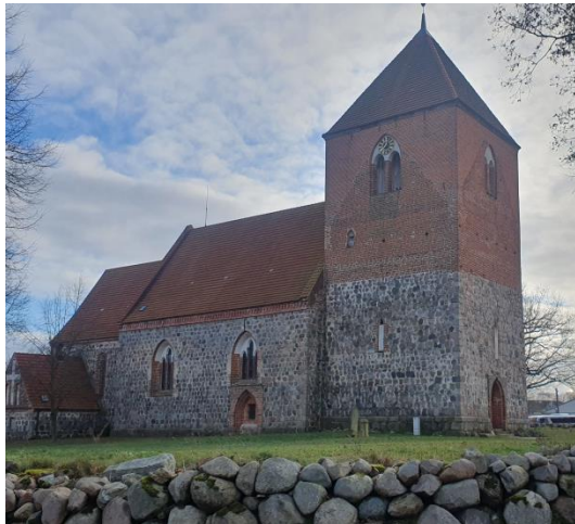
Abb.1: Kirche Lohmen mit Rüstungslöchern im Turm
