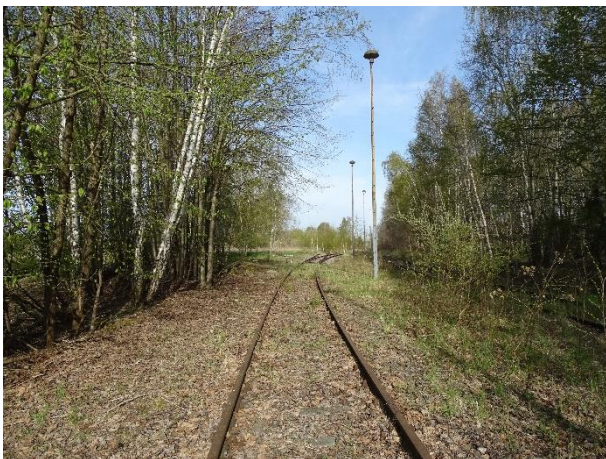
Abb. 4: Bestehende, noch wenig bewachsene Gleisanlage
