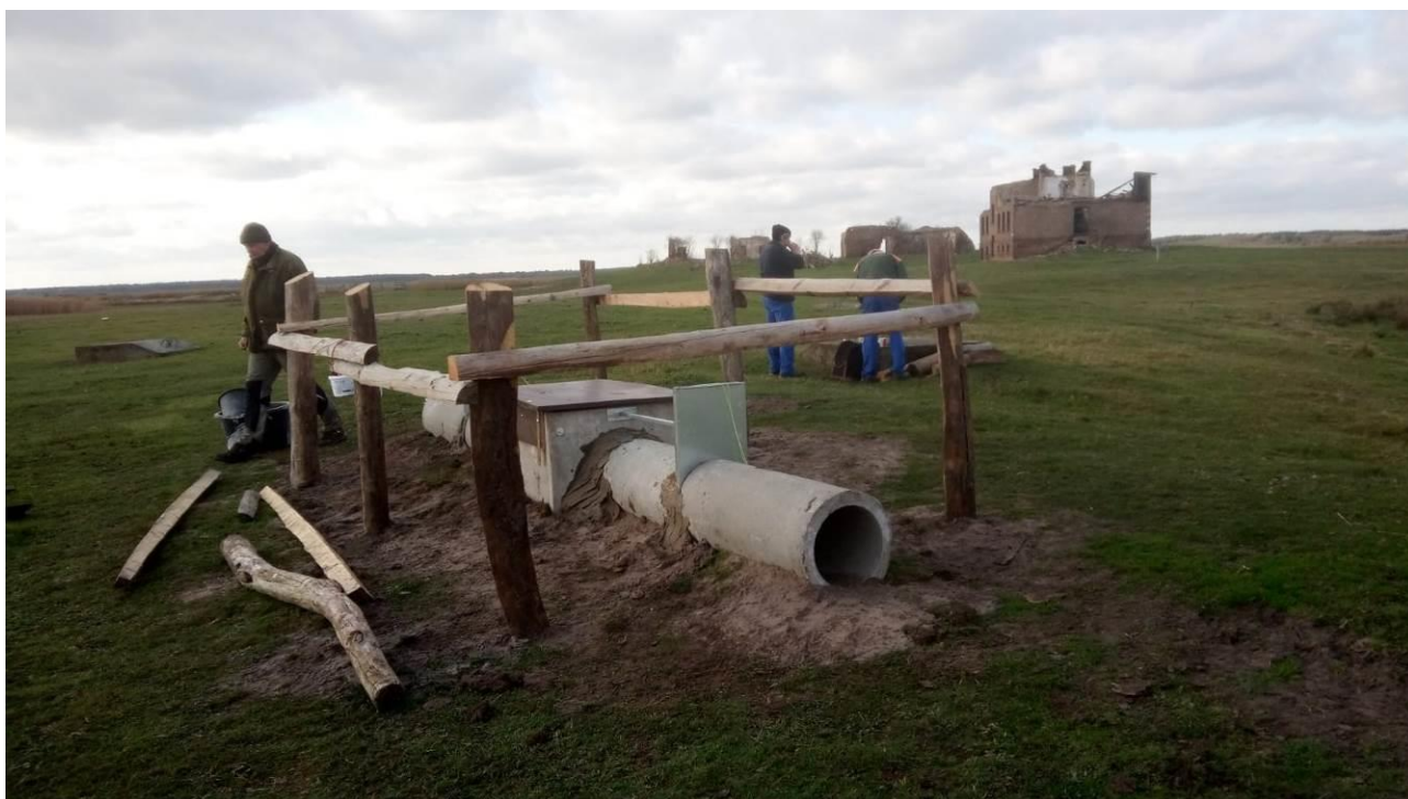
Aufbau der Betonwipprohrfalle November 2020
